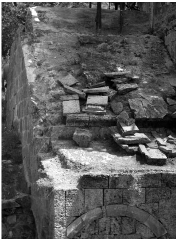
Կաթողիկե եկեղեցու հարավարևմտյան ավանդատան տանիքին հայտնաբերված ծածկասալերը
