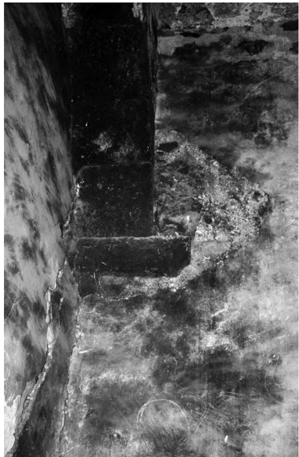
Տաճարի հարավային պատին կից որմնասյունը և արևմտյան պատի որմնախոյակի վրա հանգչող հարավային պատի որմնակամարը
