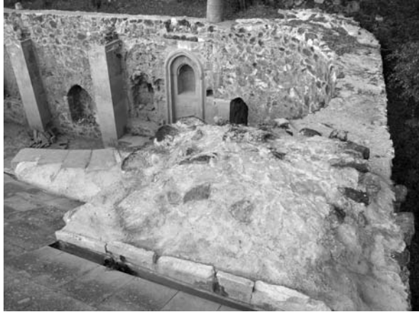
Սրբատեղիի հարավային ավանդատան տանիքն ամրակայումից հետո
