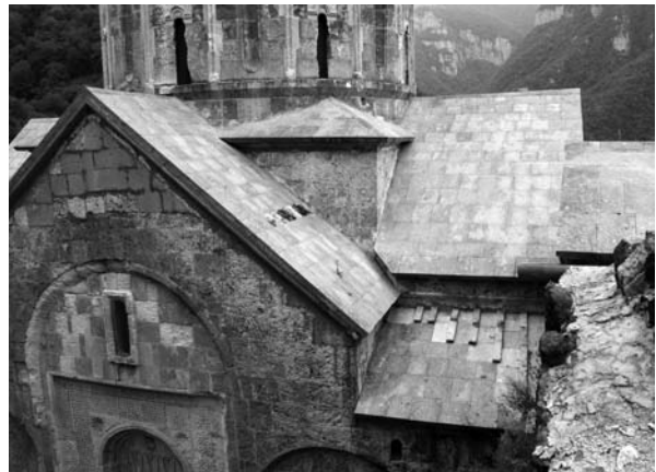
Կաթողիկե եկեղեցու՝ վերականգնված վեղարով գմբեթն արևմուտքից և վերականգնված ծածկերի հյուսիսարևմտյան հատվածը
