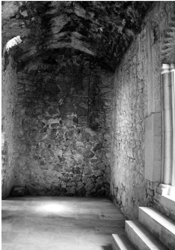
Փոքր գավթի հատակը սալապատումից հետո և դեպի սրբատեղի տանող աստիճանները
