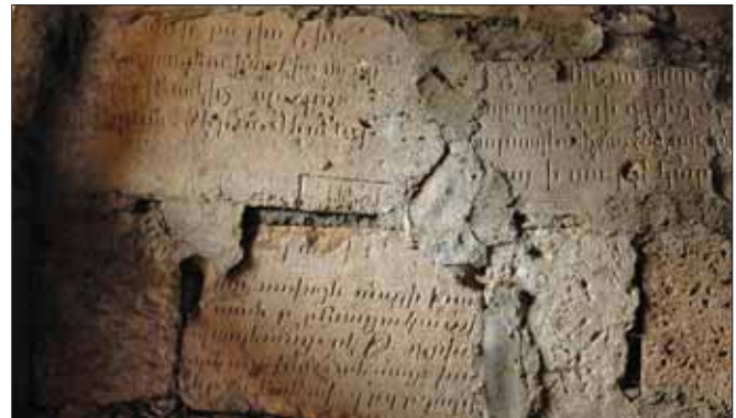
ԻՆՆԱԿՆՅԱՆ ՍՐ. ԿՐԱՂԵՏ (ՂԱԿԱԿԱՆԵ). վանքի մնացորդները 2006 թ. (լուս.՝ Սամվել Կարապետյանի) ИННАКНЯН СУРЬ КАРАПЕТ (СВ. ИОАННА ПРЕДТЕЧИ) ИЛИ ГЛАКАВАНК. Обломки сооружений монастыря и надгробных памятников его кладбища, использованные при строительстве жилых домов села, возникшего на месте монастыря (фот. Самвела Карапетяна, 2006 г.)
