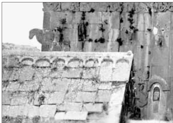
АХТАМАР. Часовня рядом с северо-восточным углом церкви Св. Креста. Фрагмент старых зубчатых плит (с цилиндрическим окончанием) перекрытия и кровля часовни после того, как была покрыта гладкими плитами
