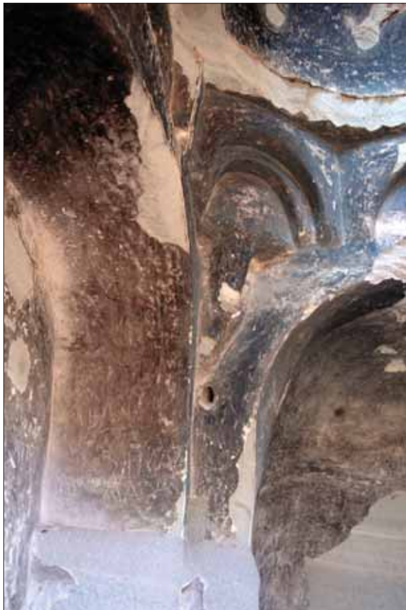
Ложный купол юго-западной часовни монастыря Царакара, внутренний вид на алтарную апсиду (север), северо-западный трюмп, и юго-западный пристенный пилон
