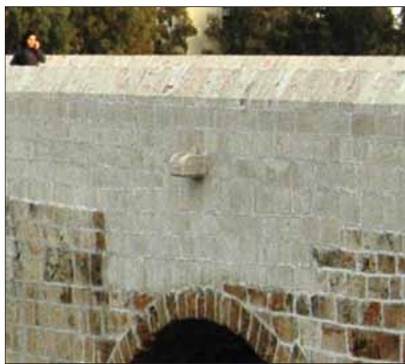
АДАНА. Общий вид отреставрированного моста и фрагмент
