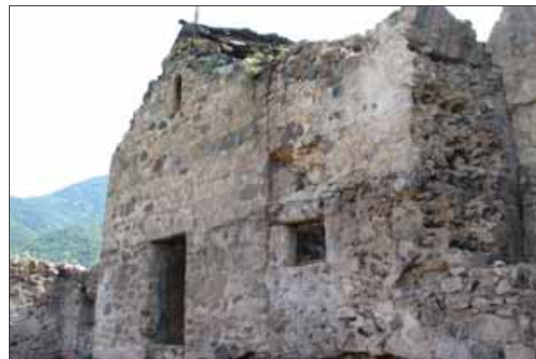
Часовня рядом с западной частью южной стены церкви
