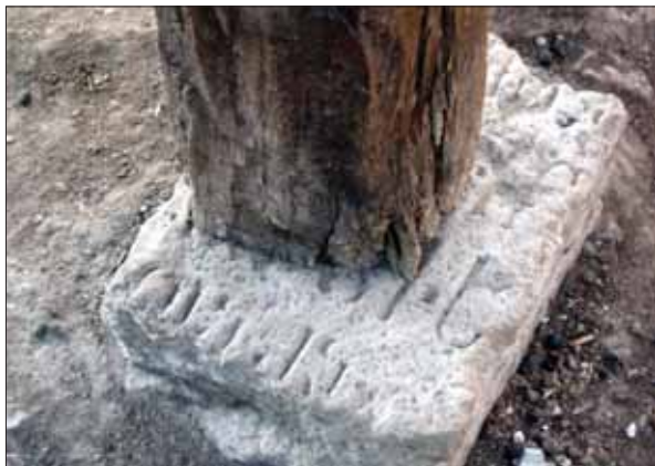
Обломок надгробной плиты с надписью, использованный как база для деревянной колонны хлева
