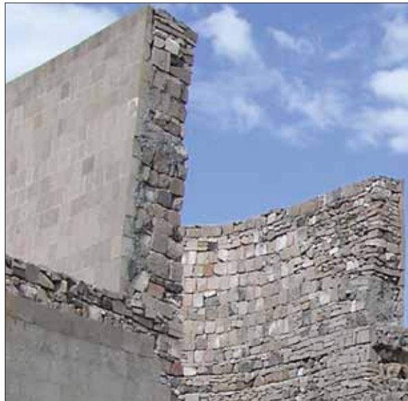
АНИ. Башни у Главных ворот до и после реставрации, фрагмент “отреставрированной” башни
