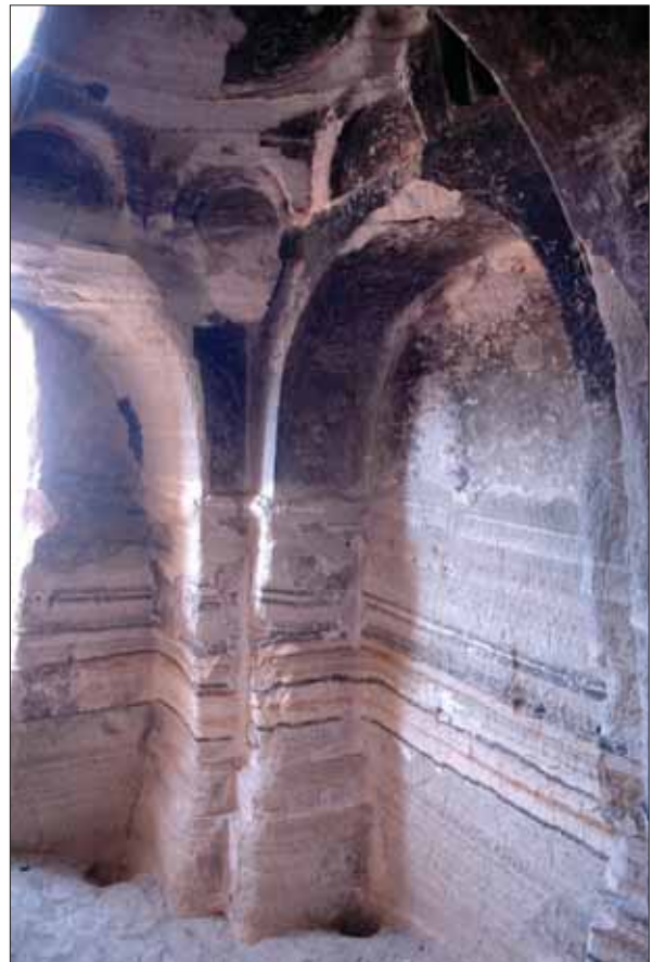
Ложный купол юго-западной часовни монастыря Царакара, внутренний вид на алтарную апсиду (север), северо-западный трюмп, и юго-западный пристенный пилон
