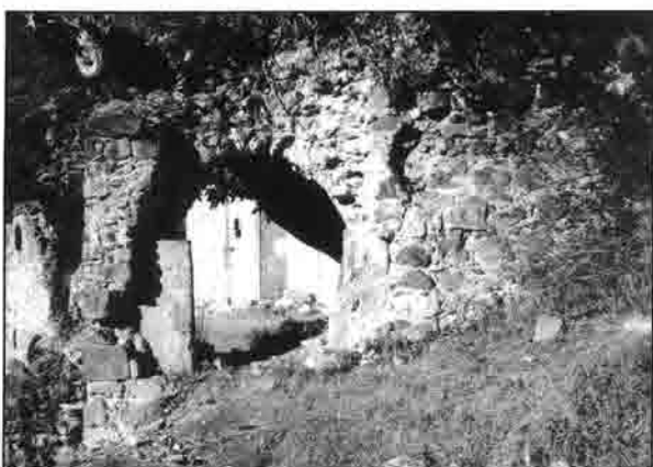
ВОРОТА: на западной и на восточной сторонах комплекса
