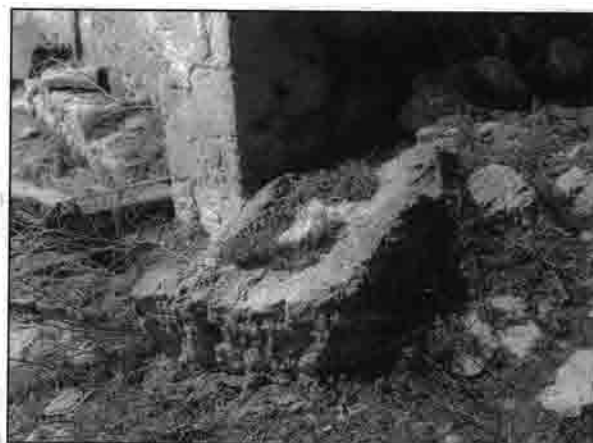
ХАРТЕК: бассейн разрушенного родника в центре села
