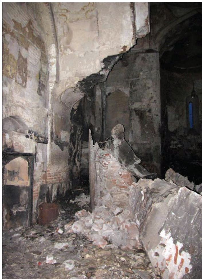
Последующие друг за другом 3 и 7 января 2012 г. пожары (их тушили запрещенным для исторических памятников методом—водой) уничтожили северо-восточную колонну церкви (фот. Н. Акопова, январь 2012 г.).
