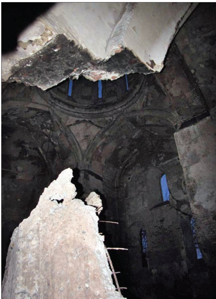
Последующие друг за другом 3 и 7 января 2012 г. пожары (их тушили запрещенным для исторических памятников методом—водой) уничтожили северо-восточную колонну церкви (фот. Н. Акопова, январь 2012 г.).
