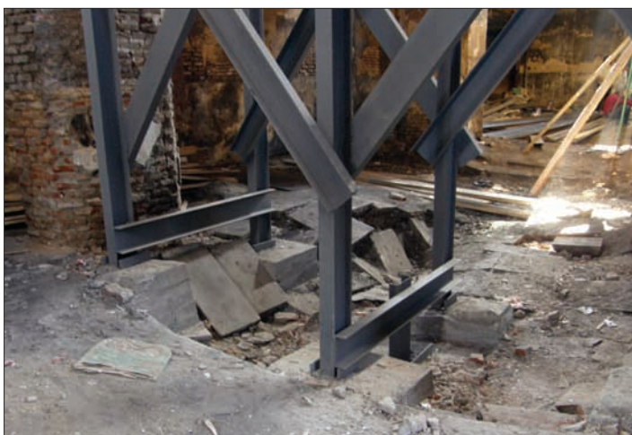
Установленные в марте-апреле 2012 г. металлические и деревянные подпорки в интерьере церкви с целью избежания возможных обвалов (фот. А. Акопяна).
