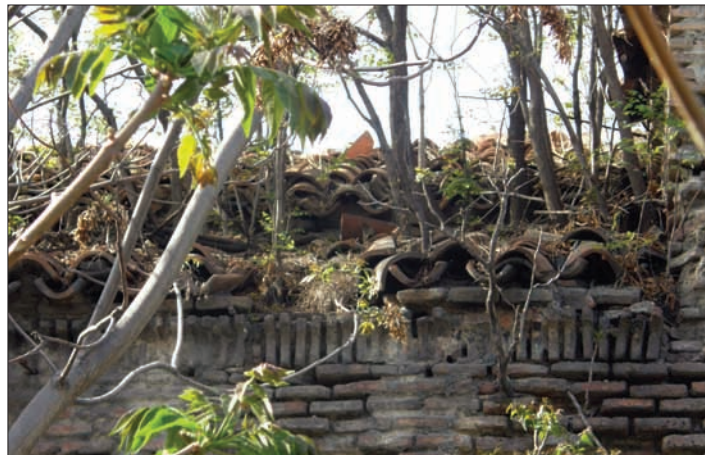
Поврежденное после пожара 2002 г. черепичное покрытие, ставшее в последующие годы более уязвимым из-за разрушительного воздействия растительности (фот. Н. Аколова, январь 2011 г. и С Карапетяна, 2007 г.).
