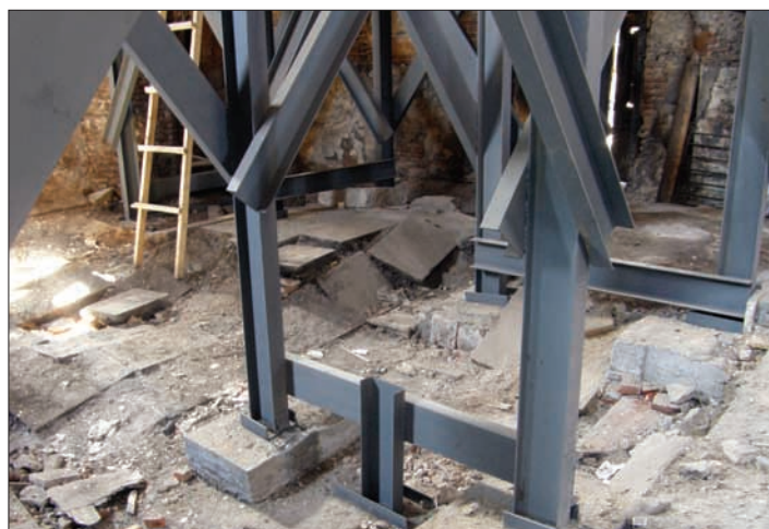
Установленные в марте-апреле 2012 г. металлические и деревянные подпорки в интерьере церкви с целью избежания возможных обвалов (фот. А. Акопяна).
