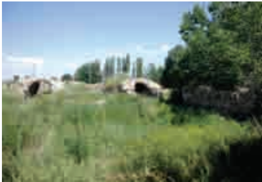
Սբ. Խաչ եկեղեցու մնացորդները Խոյ գավառի Ղորուզ գյուղում (լուս.՝ Ս. Կարապետյանի, 2011 թ.)
