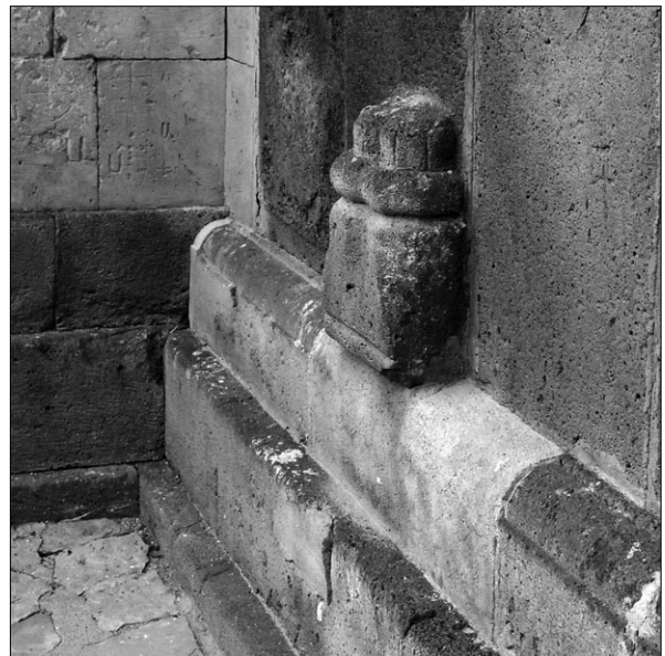
Թադեոս առաքյալի վանք. հատվածներ հիմ եկեղեցու տեղում գոյություն ունեցած ավելի հիմ եկեղեցու որմնասյուների որմնախարիսխներից
