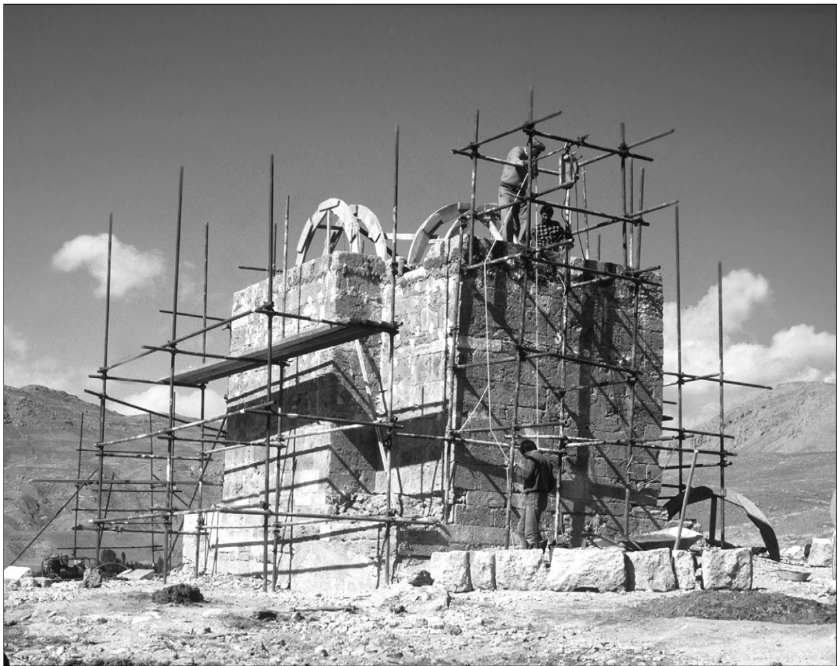
Ծործորի վանքի եկեղեցին նոր վայրում վերականգնելու ընթացքում (լուս.՝ ճարտ. դր. Արմեն Բախնազարյանի, 2000 թ.)
