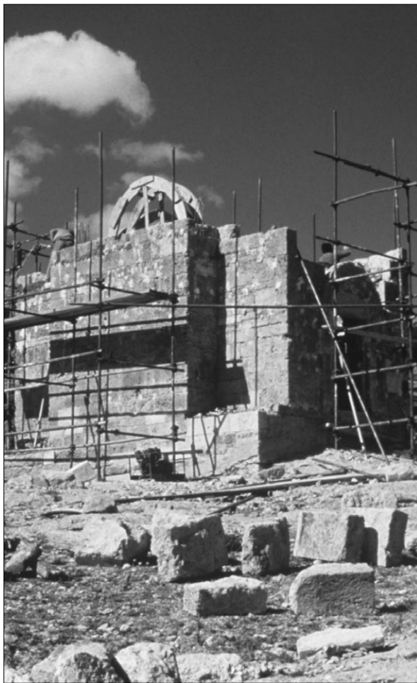
Ծործորի վանքի եկեղեցին նոր վայրում վերականգնելու ընթացքում, հատակագիծն ու հյուսիսային ճակատը
