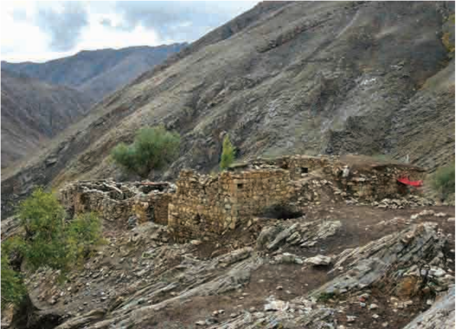
Մթ. Գևորգ վանքի ավերակները հյուսիս-արևելքից, եկեղեցին 2006 թ. (լուս. և չափ.՝ Ս. Կարապետյանի)
