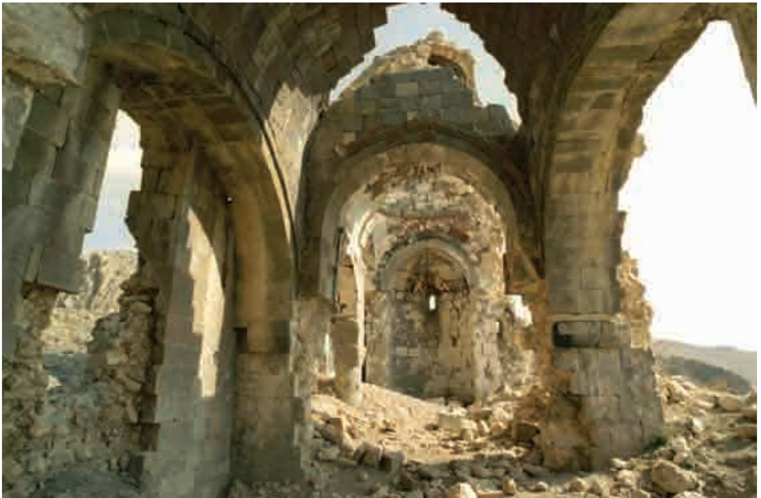
Սքանչելագործ վանքի եկեղեցու ներքին տեսքը դեպի արևելք 1972 (լուս.՝ Ճ.-Մ. Թիերրիի) և 2007 թթ. (լուս.՝ Ս. Կարապետյանի)
