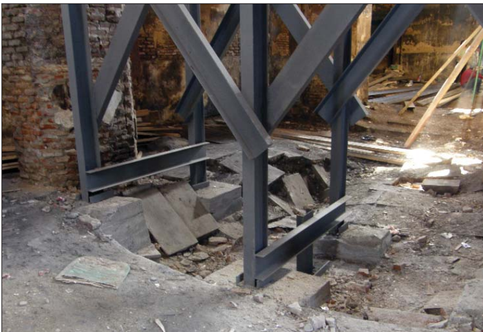
Հնարավոր փլուզումներից խուսափելու նպատակով եկեղեցու ներսում 2012 թ. մարտ-ապրիլ ամսին տեղադրված մետաղական և փայտե հենակները (լուս.՝ Ա. Հակոբյանի)
