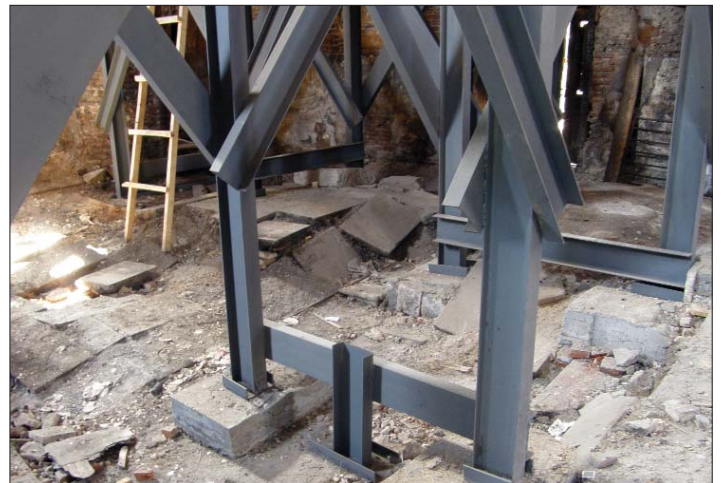
Հնարավոր փլուզումներից խուսափելու նպատակով եկեղեցու ներսում 2012 թ. մարտ-ապրիլ ամսին տեղադրված մետաղական և փայտե հենակները (լուս.՝ Ա. Հակոբյանի)
