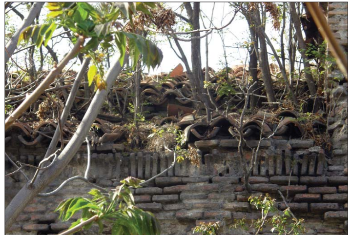
2002 թ. հրդեհի հետևանքով շարքից դուրս եկած կղմինդրածածկը հետագա տարիներին ավելի խոցելի դարձավ բուսականության ավերիչ մերգործության պատճառով (լուս.՝ Ն. Ակոպովի, 2011 թ. և Ս. Կարապետյանի, 2007 թ.)
