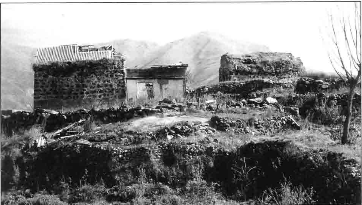
ԾԱՐ. հարավից երիզող ժայռադարը, գյուղի սեսֆն արեւմուտքից եւ Սր. Գրիգոր ու Սր. Սարգիս եկեղեցիները հյուսիսից
