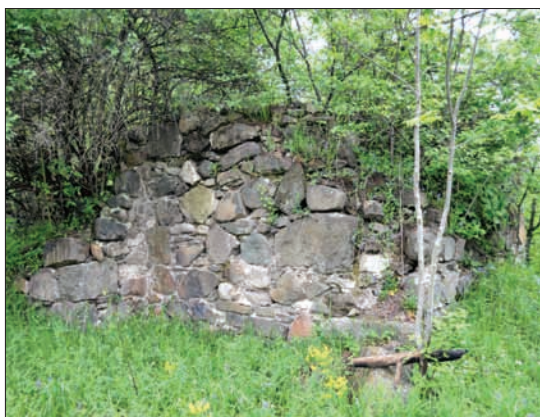
Կոպայան գյուղատեղիի եկեղեցու մնացորդները հարավ-արևելքից և արևելքից The remnants of the church of Kalapan Village Site from the south-east and east
