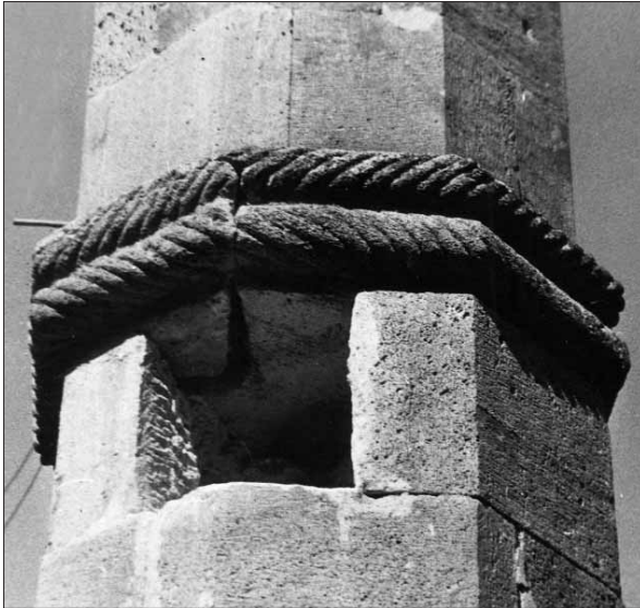
Տեղաշարժված քարը հանելուց հետո երևում է միջնագոտու կենտրոնի անցքը, 1987 թ.
