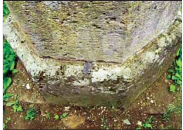
Խարսխի երկու աստիճանների միացման հանգույցում տեղադրված ձողաքանոնը, 2014 թ.
