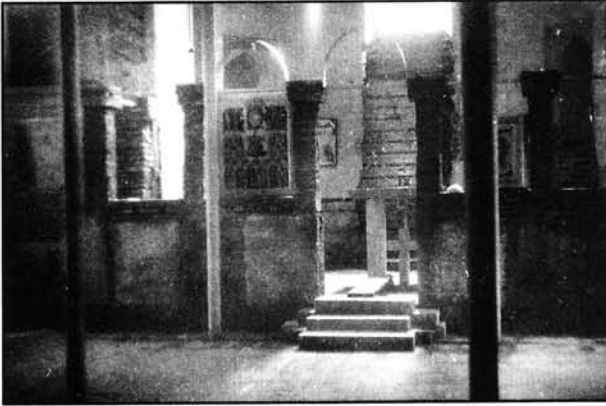
▲ Մի պահ եկեղեցու խորանի բարձր բեմը քանդելուց հետո հունաձես եկեղեցիներին բնորոշ բեմառաջի պատմեշի կառուցման ընթացքից (1995թ.)
