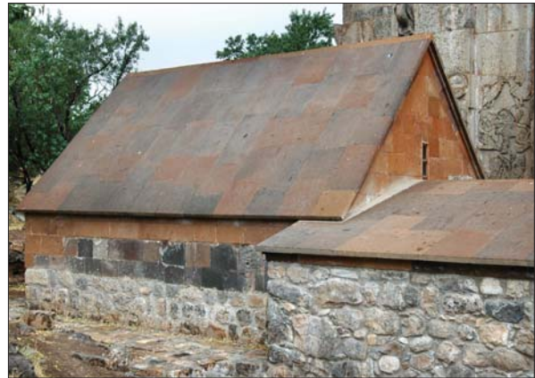
ԱՂԹԱՍԱՐ. Սբ. Խաչ վանքի հյուսիսարևելյան անկյան մոտ գտնվող մատուռը. հատված գլանաձև վերջույթներով ատամնաշար հին ծածկասալերից և մատուռի տանիքը հարթ սալերով երեսապատումից հետո
