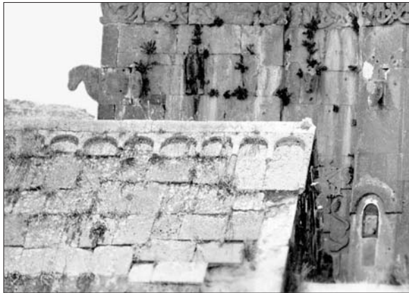
ԱՂԹԱՍԱՐ. Սբ. Խաչ վանքի հյուսիսարևելյան անկյան մոտ գտնվող մատուռը. հատված գլանաձև վերջույթներով ատամնաշար հին ծածկասալերից և մատուռի տանիքը հարթ սալերով երեսապատումից հետո
