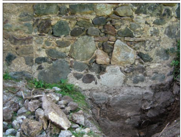
Նկ. 22-23. արևելյան կողմի դիաթաղումները և Դաղի եկեղեցու արևելյան պատի բացված հիմնապատը (լուս.՝ Ս. Այվազյանի, 2008 թ.)
