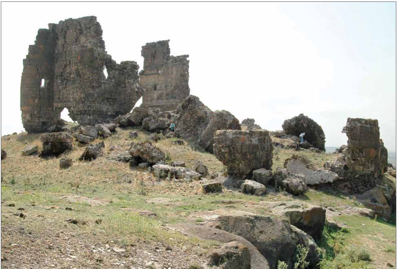
ՏԻԳՆԻՍ ԳՅՈՒՂ. Տիգնիսի բերդի ընդհանուր տեսքը հյուսիս-արևելքից (լուս.՝ ճարտ. Թորոս Թորամանյանի, 1900-ական թթ.) և բերդի մնացորդները (լուս.՝ Սամվել Կարապետյանի, 2005 թ.) TIGNIS VILLAGE. A general view of the castle of Tignis from the north-east (photo by architect Toros Toramanian, 1900s); the remnants of the castle (photo by Samvel Karapetian, 2005)
