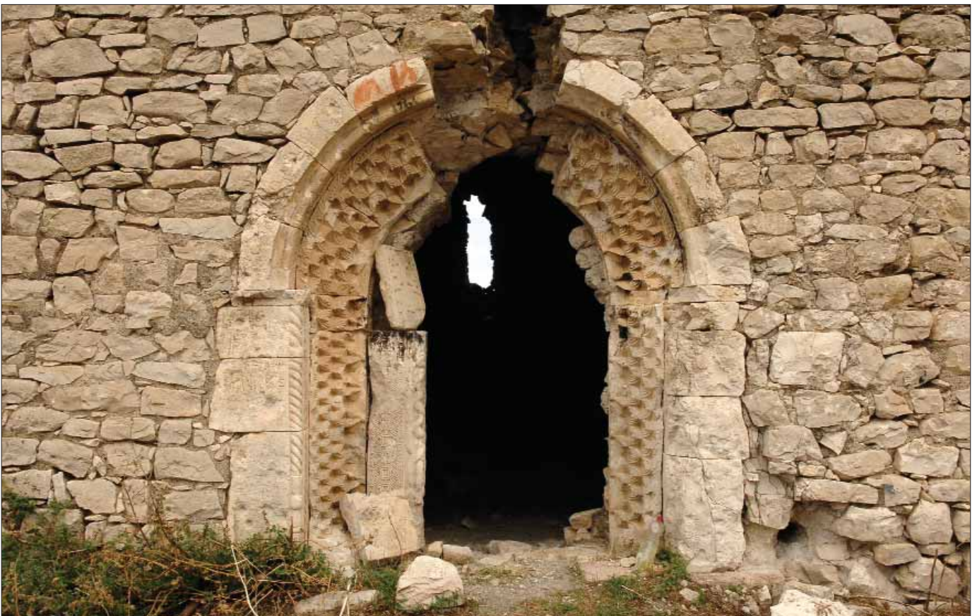
ՀՈԴԵՐ ԳՅՈՒԴ, ՀԱՂՐՈՒԹԻ ՇՐՋԱՆ. Կավաք վանքի եկեղեցու մուտքը՝ 1742 թ. շինարարական արձանագրությամբ (1982 թ.) և ազատագրումից հետո՝ 2009 թ. (լուս.՝ Ս. Կարապետյանի)
