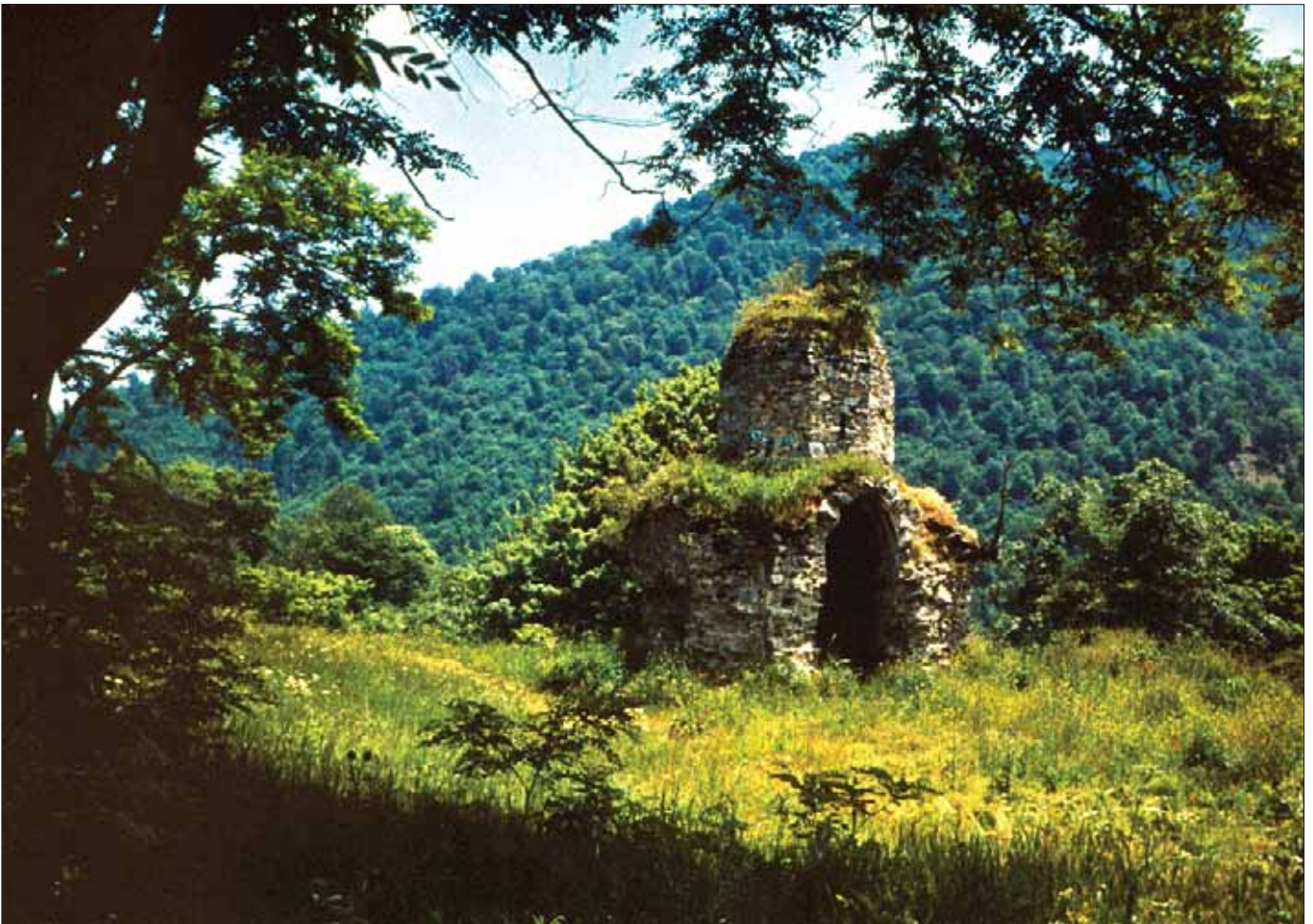
ԳԵՏԱԲԱԿ, ՀՅՈՒՄՍԻԱՅԻՆ ԱՐՑԱՆՍ. Սբ. Սարգիս վանքի խաչաձև-գմբեթավոր հորինվածքով եկեղեցին, Թ-ԺԱ դդ., (գծանկարը՝ Լեհման Հաուպտի, լուս.՝ Ս. Կարապետյանի, 1980 թ.) GETABAK, NORTHERN ARTSAKH. The domed cruciform church of St. Sargis Monastery, 9th to 11th cents. (graphical drawing by Lehmann Haupt, 2nd and 3rd photos by Samvel Karapetian, 1980)
